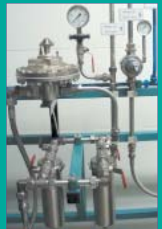
Detailansicht: Pulsationsdämpfer, Doppelfilter-armatur, Rücklaufregler
